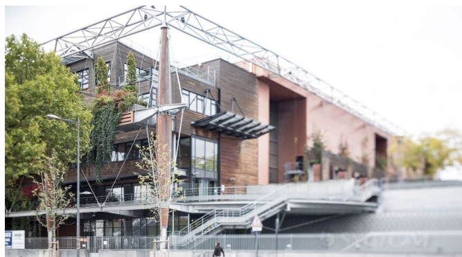
Le centre de traitement multifilière Isséane à Issy-les-Moulineaux
