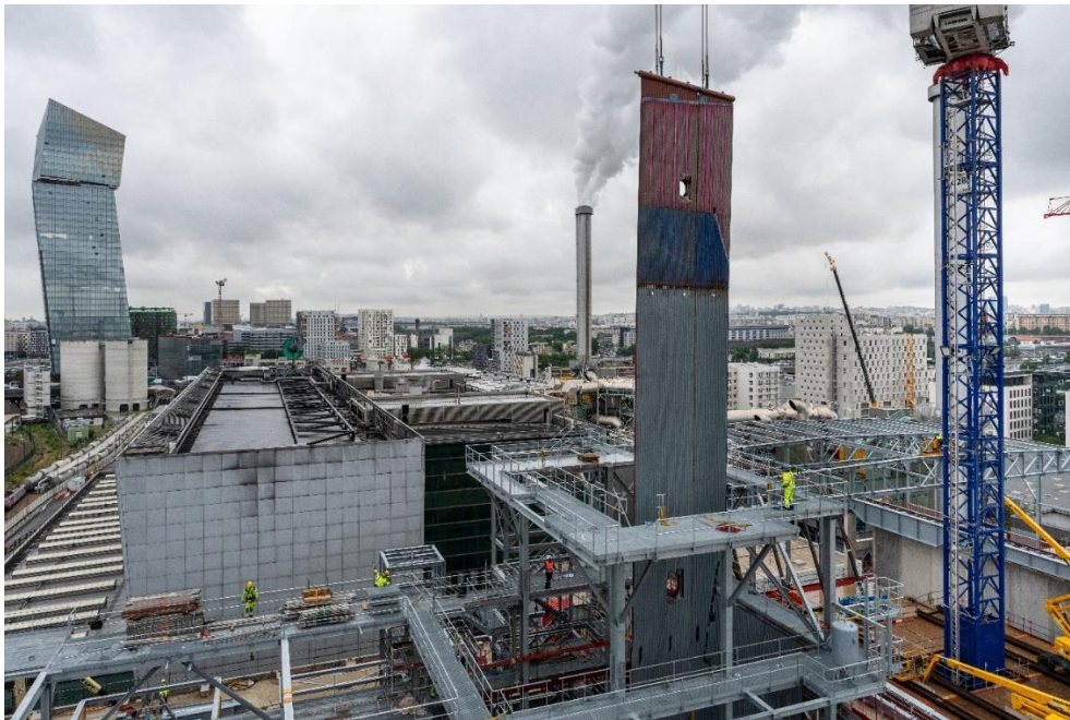
Grutage du premier panneau latéral de la chaudière n°1 – juin 2021
