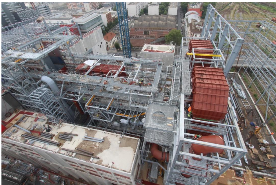
Installation des deux filtres à manches
