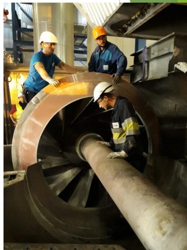
Intervention roue ventilateur de tirage
