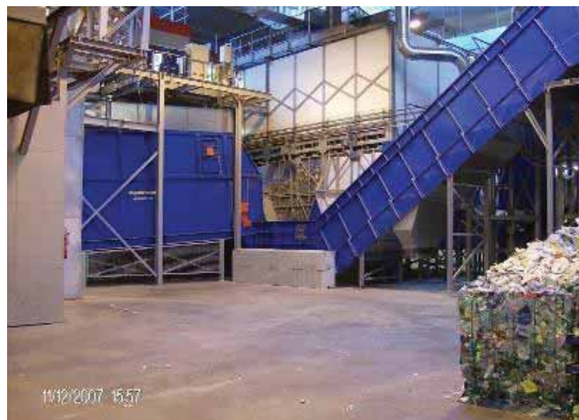
Figure 9 : Photo de la zone de conditionnement de mise en balles de la collecte sélective
