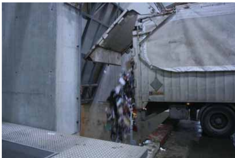
Figure 10: Déchargement d'ordures ménagères en fosse
