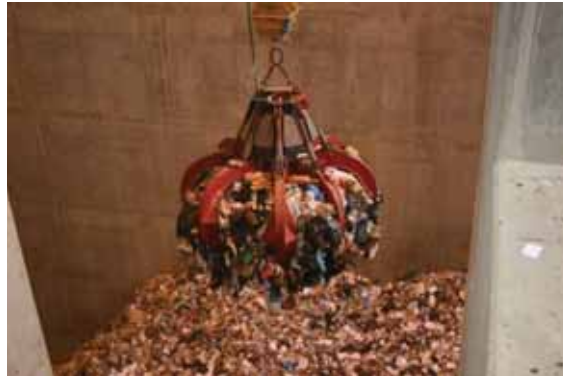
Figure 11: Grappin sur pont-roulant en fosse
