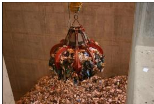
Figure 11 : Grappin sur pont-roulant en fosse
