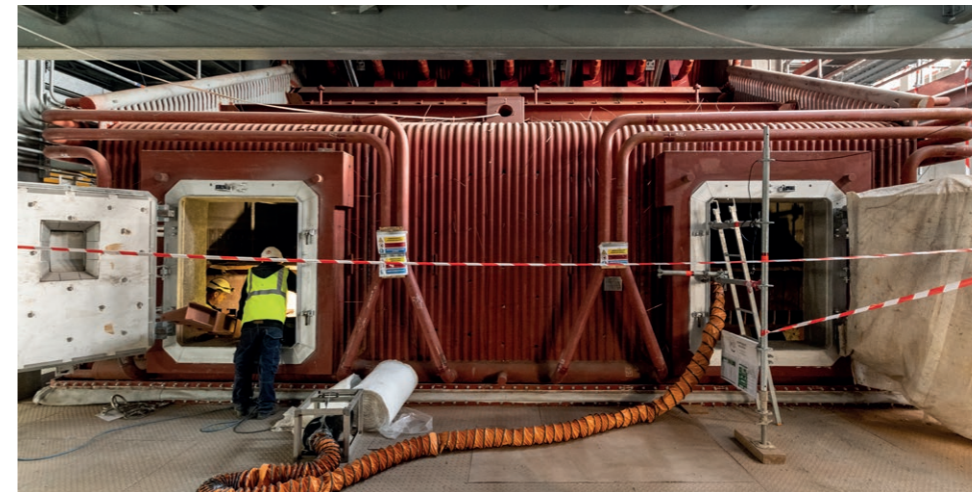
Porte d'accès à l'intérieur du four au niveau du plan de grilles.
