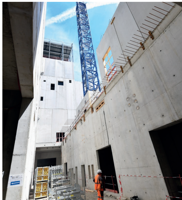
Zone de stockage des réactifs du traitement des fumées en construction.
