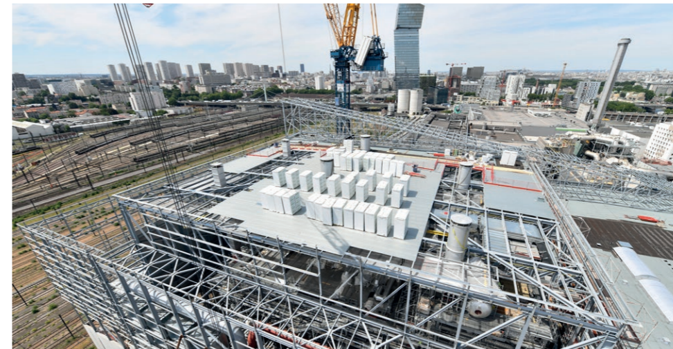
Vue aérienne de la toiture du bloc fours/Chaudières / traitements des fumées.
