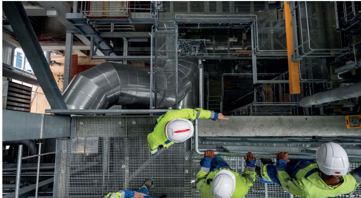
● Passerelles d'accès aux équipements de traitement des fumées.
